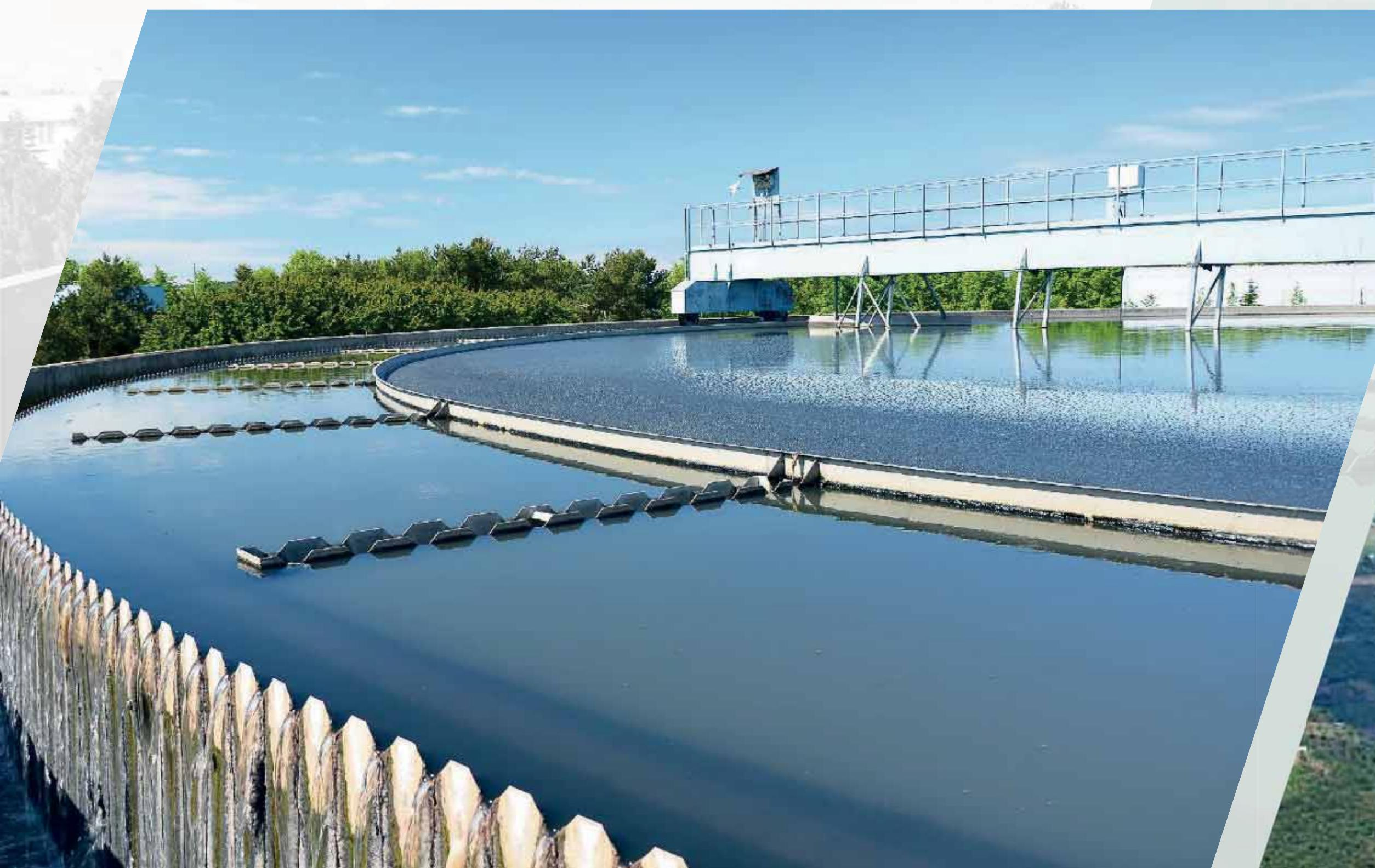
Водопроводное очистное сооружение, которое обеспечивает экологически чистую питьевую воду провинции Сакарья, было построено в 2013 году с использованием самых передовых технологий очистки воды. Производительная мощность данного очистного сооружения составляет 5,5 млн. кубометров воды в год.
